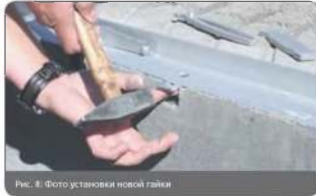
Рис. 9: Фото удара сменной гайки
